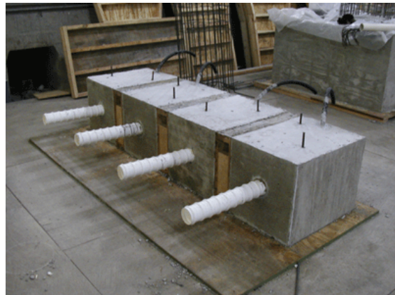
(d) Completed blocks
